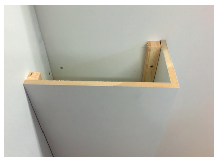
Kotelo on mahdollista kiinnittää myös rimoitukseen tai peltisiin kiinnityskulmiin.
